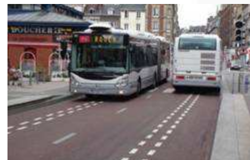
Marquage au sol qui sert de guidage optique pour l'accostage en station.
